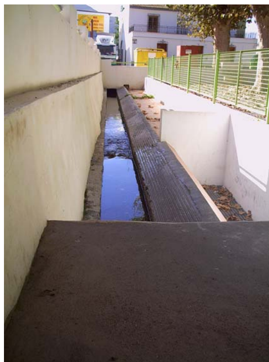
Lavadero (Punto 4 de la fig. 7) (Jorge Jiménez Sánchez)
